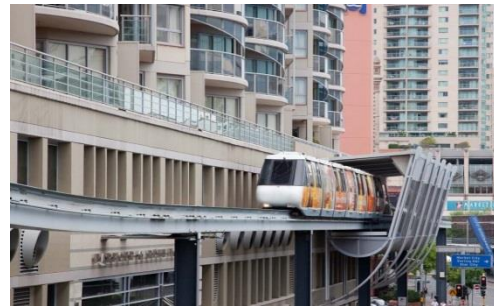
Рис. 4. Монорельсовая дорога в городе Сидней (Австралия), представлена как часть многоэтажного здания 12 .
